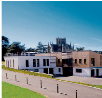
Unité de Soins Sans Consentement « Sainte-Camille » : construction d'un nouveau bâtiment (début travaux janvier 2018, déménagement octobre 2019, inauguration novembre 2019)
