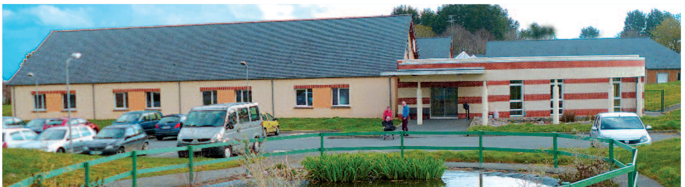
Agrandissement et réaménagement de la Maison d'Accueil Spécialisée | 2020 | 2 200 000 €
