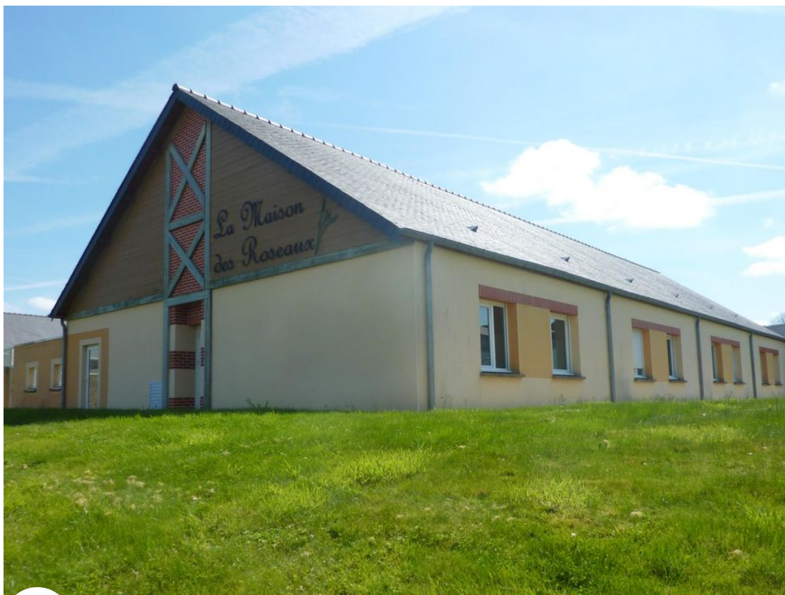
Image 1 sur 4 Maison des Roseaux
